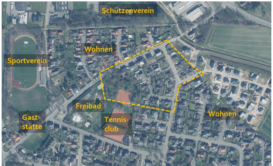
Abb. 5 Übersicht über die umliegenden Nutzungen (Quelle Luftbild: LGLN)
