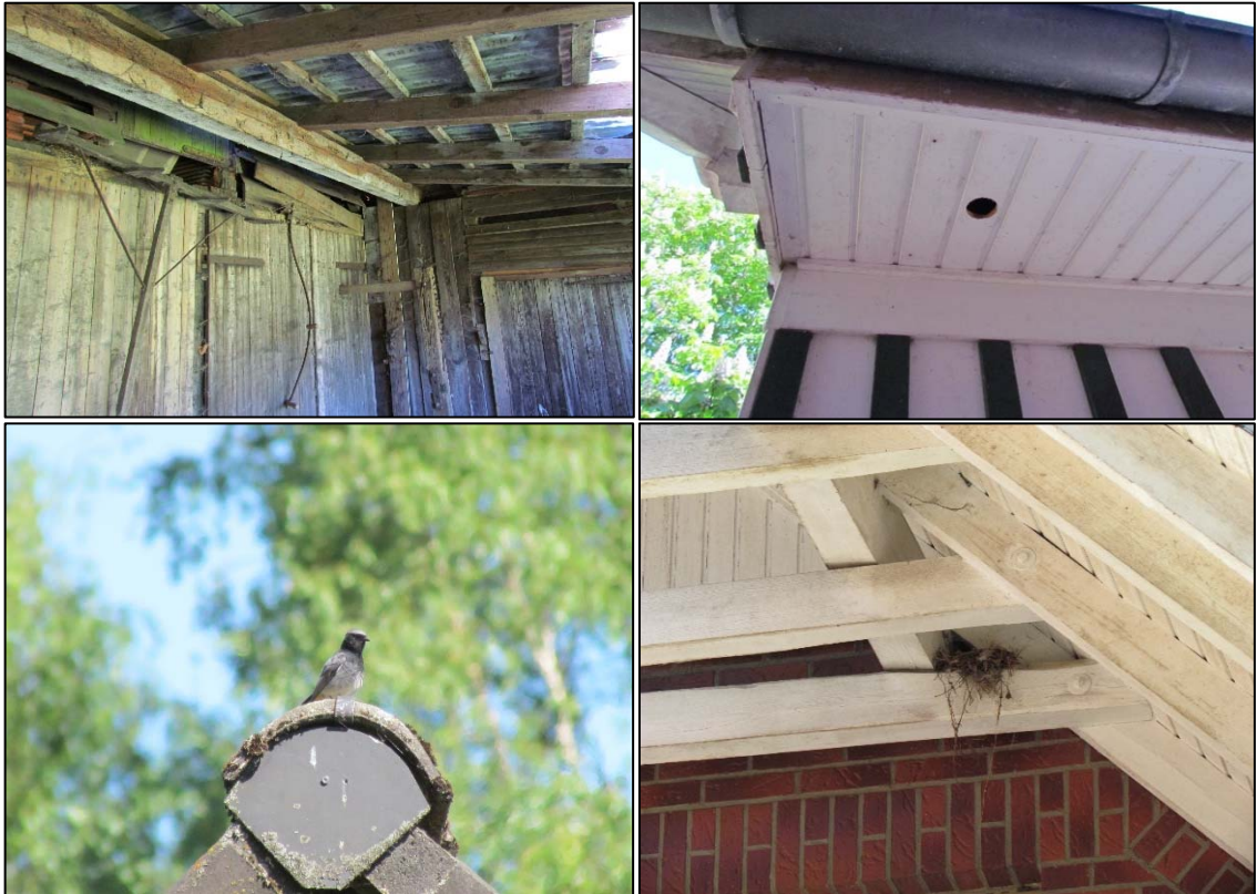
Abb. 4: Verschiedene (potenzielle) Bruthabitate für Höhlen- und Nischenbrüter an den vorhandenen, überplanten Gebäuden, unten links: Hausrotschwanz am vermutlichen Brutplatz
